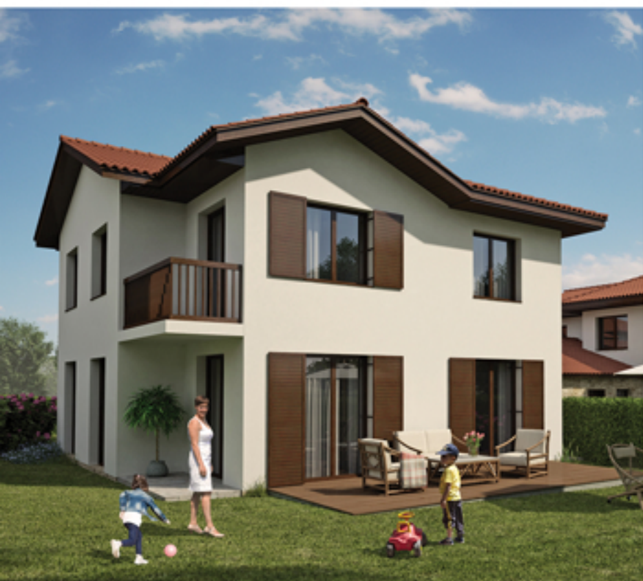
ИЗГЛЕД ПОСОКА ЮЖНА ФАСАДА
