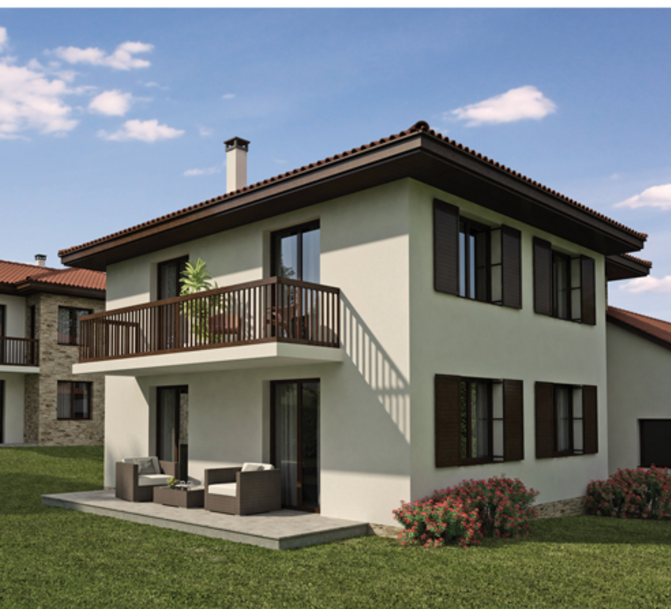
ИЗГЛЕД ПОСОКА ЮЖНА ФАСАДА
